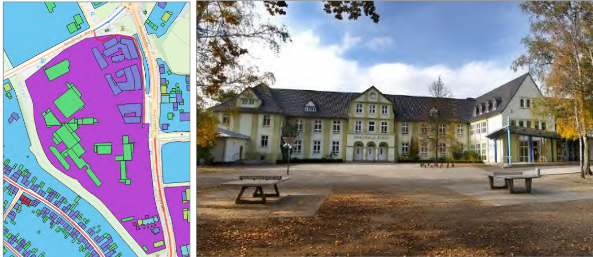
Abbildung 79: Baublock mit städtischem Gymnasium Selm und Overbergschule (links), Overbergschule Selm (rechts)
