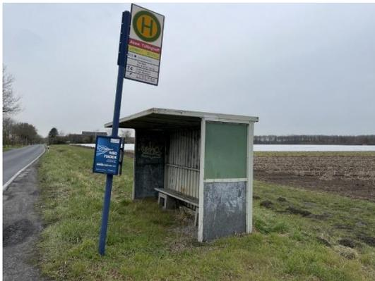
Abbildung 95: Fehlende Barrierefreiheit sowie mangelhafter Komfort (Haltestelle „Abzw. Tüllinghof“)
