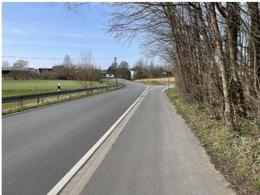
Abbildung 90: Fehlender Sicherheitsraum zwischen dem Seitenraum und der Fahrbahn (Südkirchener Straße (K6); Höhe Einmündung Buxfort)
