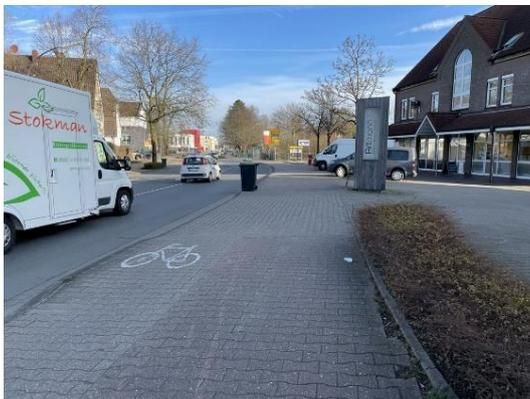
Abbildung 62: Fehlende taktile Elemente zwischen dem Geh- und Radweg (Mangel Nr. 119)
