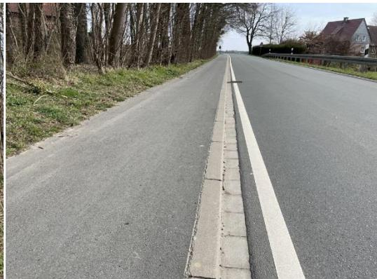
Abbildung 91: Fehlender Sicherheitsraum zwischen dem Seitenraum und der Fahrbahn (Südkirchener Straße (K6); Höhe Einmündung Buxfort)
