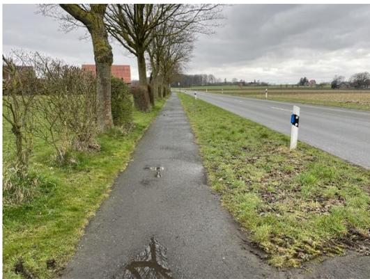
Abbildung 93: Schäden im Oberflächenbelag (v.a. Wurzelaufrüche) | Vinnummer Straße
