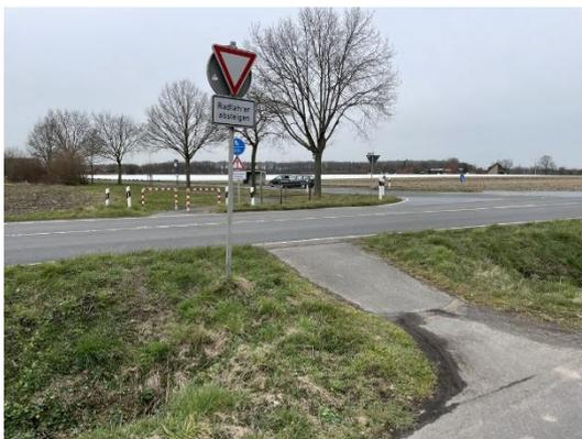
Abbildung 73: Fehlende Querungsanlage an einem Knotenpunkt (Lüdinghausener Str. (L 835)/ Tüllinghofer Straße (K 25))
