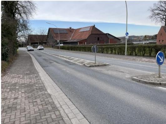
Abbildung 75: Tiefe der Querungsanlage für den Radverkehr unzureichend (Lünener Straße (B 236); Höhe Einmündung „An der Bleiche“)
