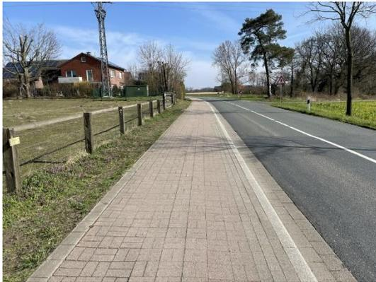
Abbildung 88: Fehlender Sicherheitsraum zwischen der Radverkehrsanlage und der Fahrbahn (Netteberger Straße | K8)
