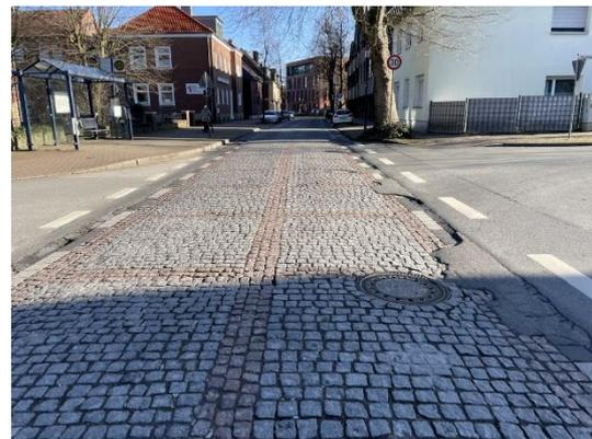
Abbildung 94: Schäden im Oberflächenbelag (Ludgeristraße)
