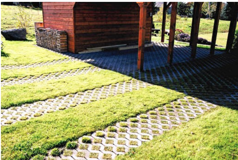
Abbildungen 20 und 21: durch Rasengittersteine befestigte Einfahrten
