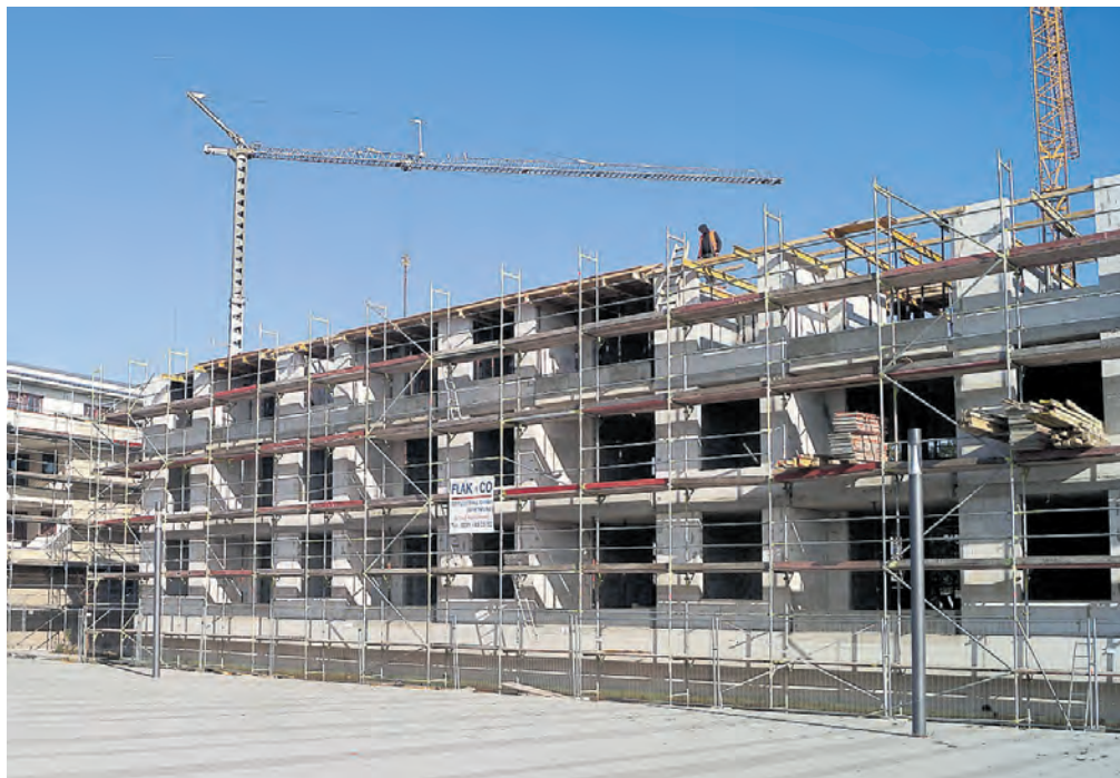
Im März 2020 sollen die ersten Mieter am Campus einziehen.
