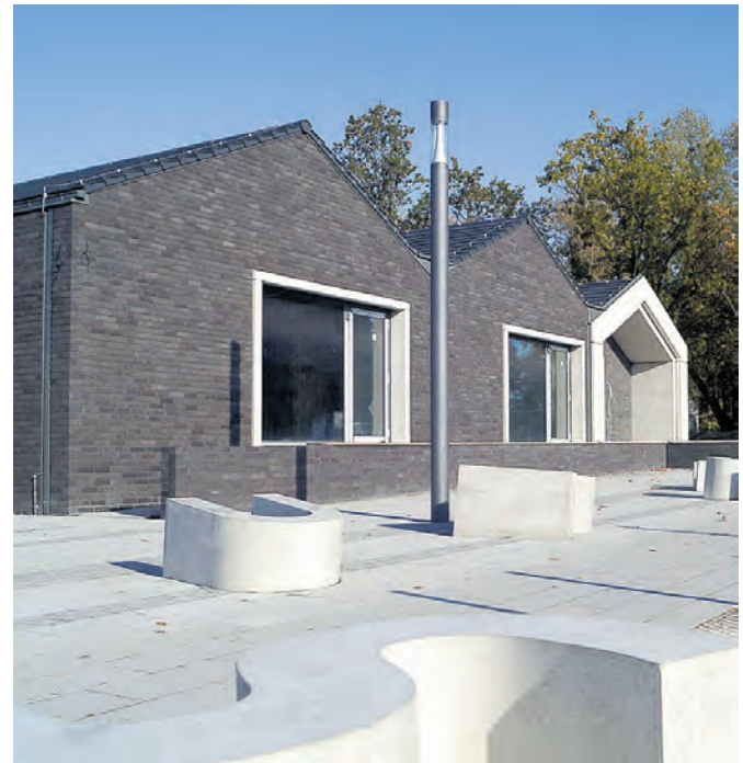
So sieht die Vorderseite des Jugendzentrums Sunshine aus.
