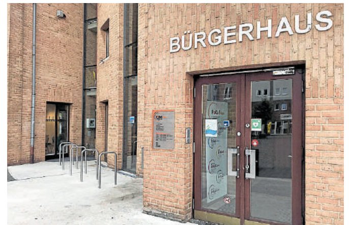
Insgesamt zehn neue Radständer aus Edelstahl wurden vor dem Bürgerhaus aufgebaut.
