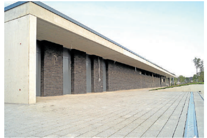
Der Rohbau des Umkleidegebäudes ist fertig. Nun steht der Innenausbau an.
