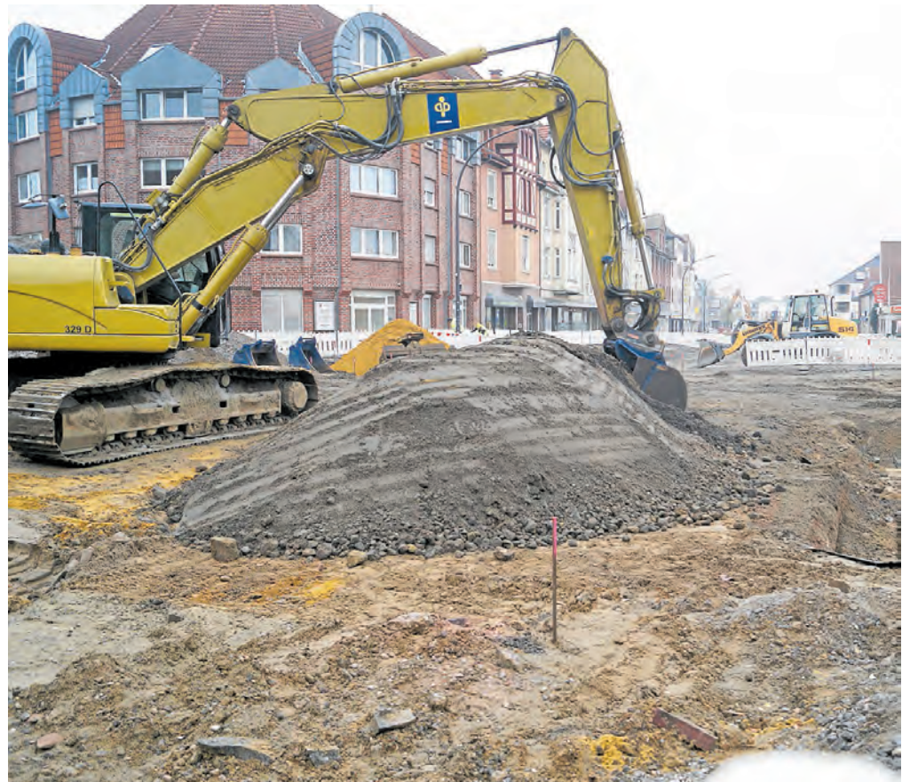
Die Baustelle auf der Kreisstraße stand im Mittelpunkt der Bürgerversammlung am 25. Oktober.
