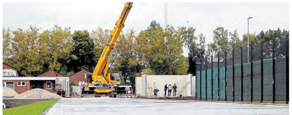
Die Bauarbeiten am Campus und am neuen Umkleidegebäude sind in vollem Gange. FOTO MALTE WOESMANN/STADT SELM
