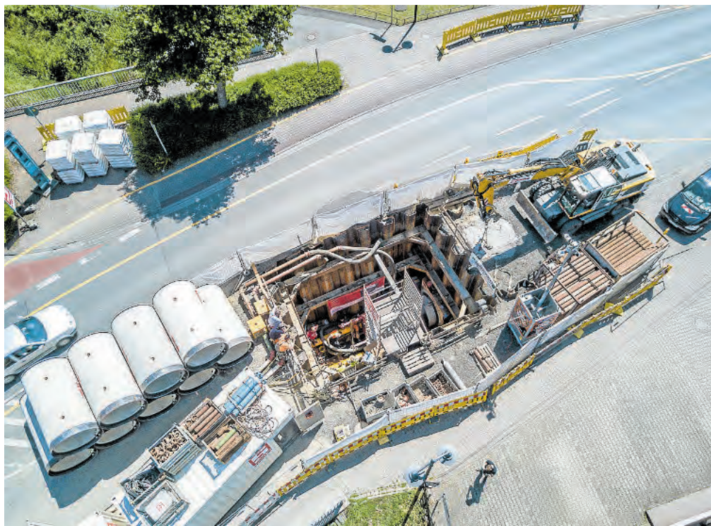
In Höhe des Selmer Baches ist die Startgrube für den Regenwasserentlastungskanal. Von hier aus werden die 1,4 Meter breiten Rohre vorgetrieben.
