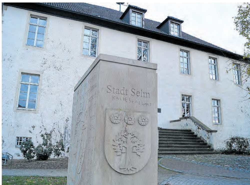
Für den Umbau der Burg Botzlar gibt es 2,7 Millionen Euro an Fördermitteln.
