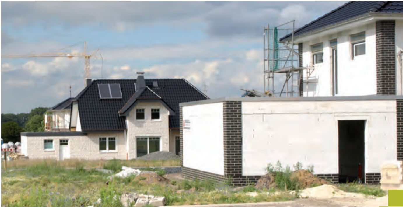
Neue Einfamilienhäuser stehen kurz vor der Fertigstellung
